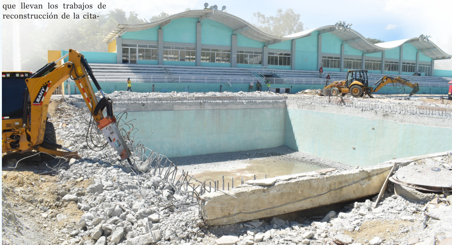
Equipos trabajan en forma acelerada en la reconstrucción Centro Acuático del Centro Olímpico Juan Pablo Duarte.
