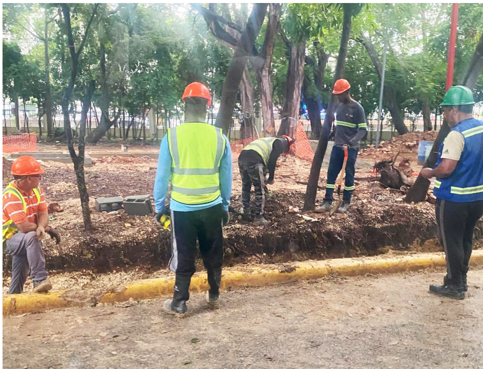
Obreros trabajan en la remodelación y construcción en diferentes áreas del Centro Olímpico.
