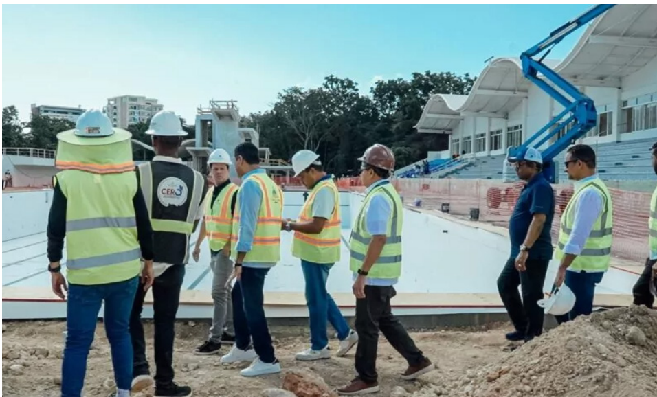
Técnicos y autoridades supervisan la fase final de las obras en el Centro Olímpico Juan Pablo Duarte.
